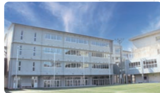
□1号館 東棟 2022年 3月完成!
